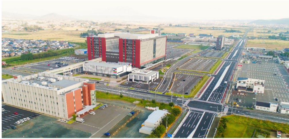
町道中央1号線道路改良その1工事
