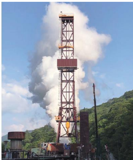
当社所有・最新鋭の3,000m級大型掘削リグ 地下のターゲットに向けて地熱井を掘削する
